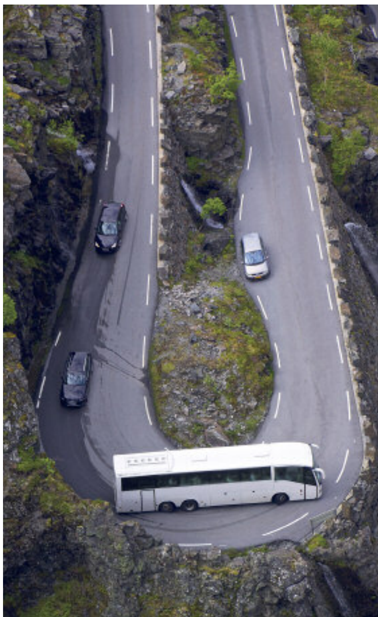
Ikke veldig god plass for lange busser i hårnålsvingene på Trollstigveien.
