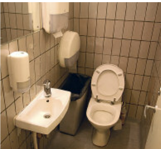
Slik skal det være! Toalett ved pauserommet på Helsfyr T-banestasjon.
