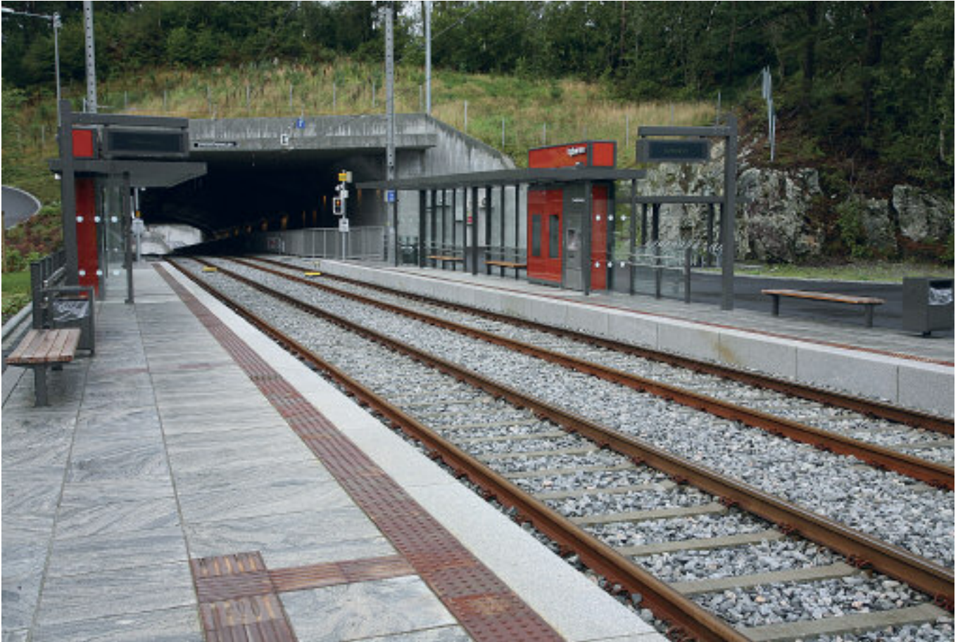
Bybanens siste utbygging har blitt en estetisk og brukervennlig fest.
