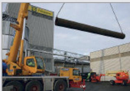
Mobilkranen losser storvokste pipe-løp til Felleskjøpets anlegg mellom Ski og Ås.
